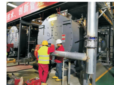
锅炉低氮改造
